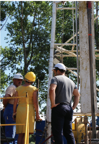
Rok. 2019. Odwiert dwóch studni głębinowych w Rekcinie. kanalizacji deszczowej.
